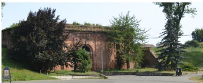
Figura 9.38: Vista facciata interna alla Cittadella di Porta Reale. Fonte: immagine scattata dall'autrice il giorno 14 luglio 2013 alle ore 15 con una macchina fotografica Nikon modello "Coolpix 5".
