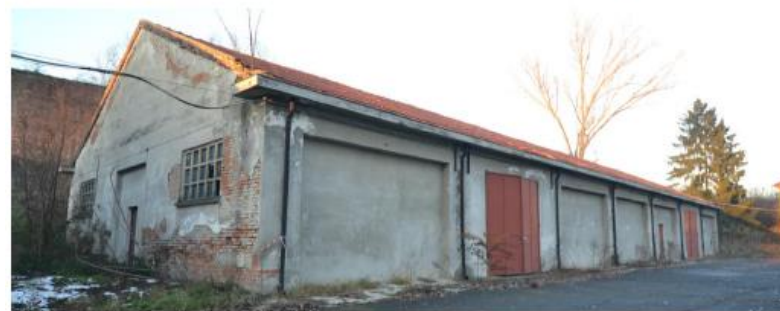
Figura 9.95: Facciata sud di un capannone.
