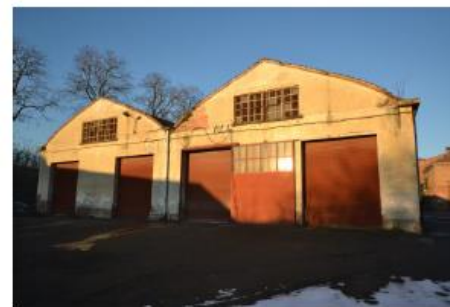
Figura 9.94: Facciata est di un capannone.
